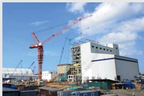
菲律宾普丁巴图燃煤电站项目
