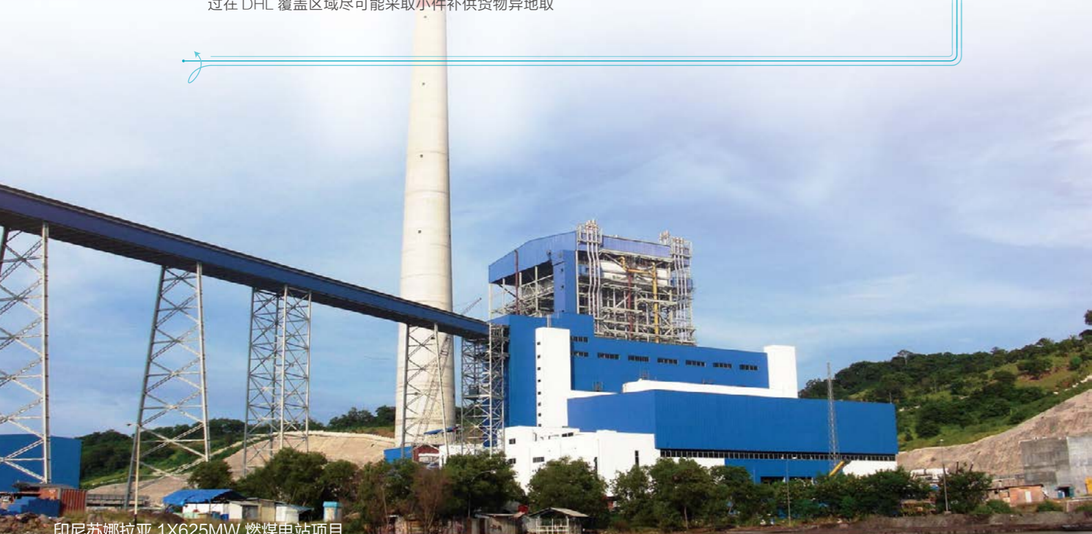
印尼苏娜拉亚 1X625MW 燃煤电站项目
