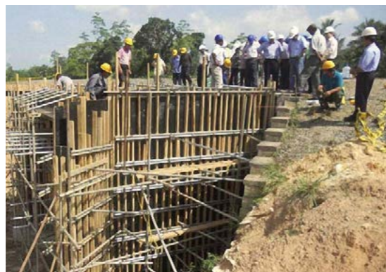
斯里兰卡南部高速公路项目涵洞施工脚手架支护安全检查
