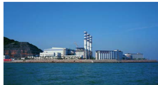
前湾燃机电厂全厂图
