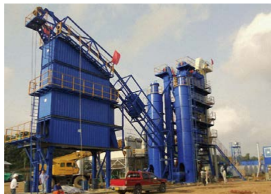
斯里兰卡南部高速公路项目设备安全性能检查
