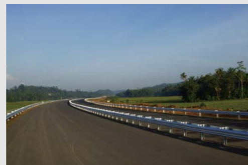
斯里兰卡南部高速公路项目
